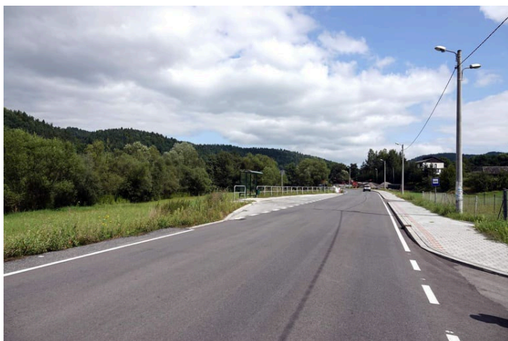
Rysunek 17. Wybrane zadania zrealizowane w ramach remontów dróg powiatowych w 2021 roku
