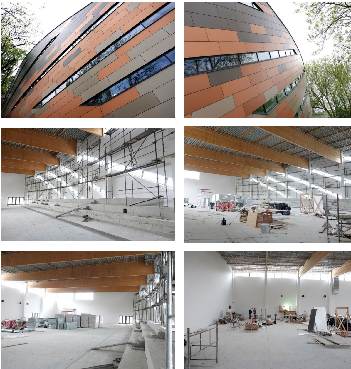
Rysunek 8. Budowa hali sportowej wraz ze strzelnicą przy Zespole Szkół im. Władysława Orkana w Marcinkowicach
