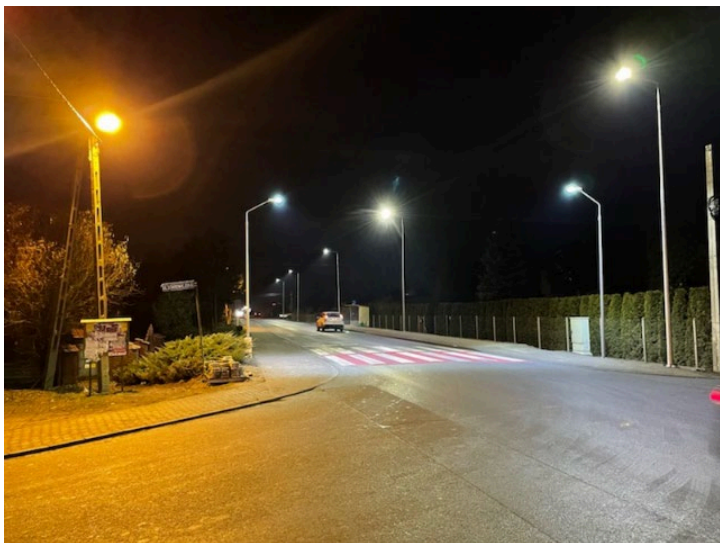
Rysunek 16. Zadania zrealizowane w ramach budowy przejść dla pieszych w 2021 roku
