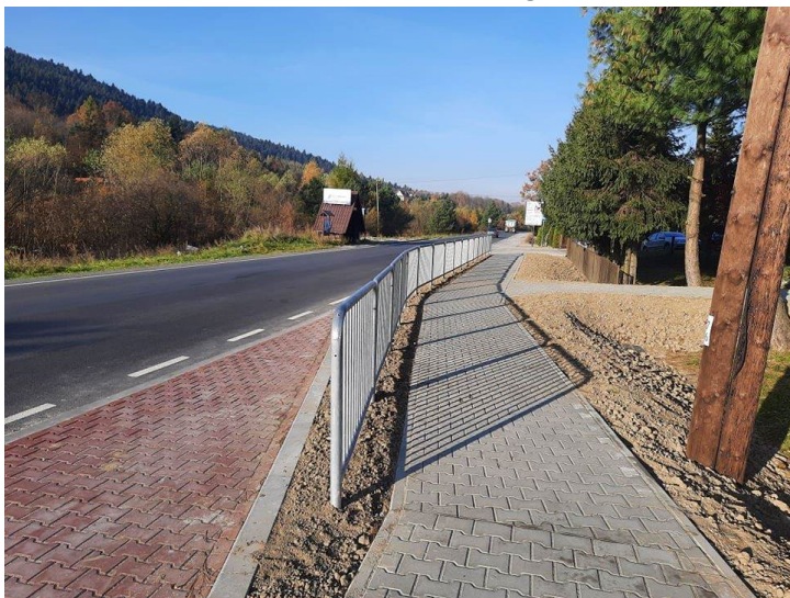
Rysunek 15. Wybrane zadania zrealizowane w ramach przebudowy i modernizacji dróg oraz chodników w 2021 roku
