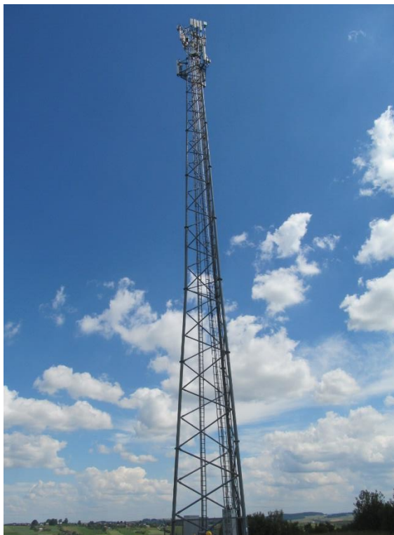
Zał. nr 1: Widok ogólny instalacji radiokomunikacyjnej.
