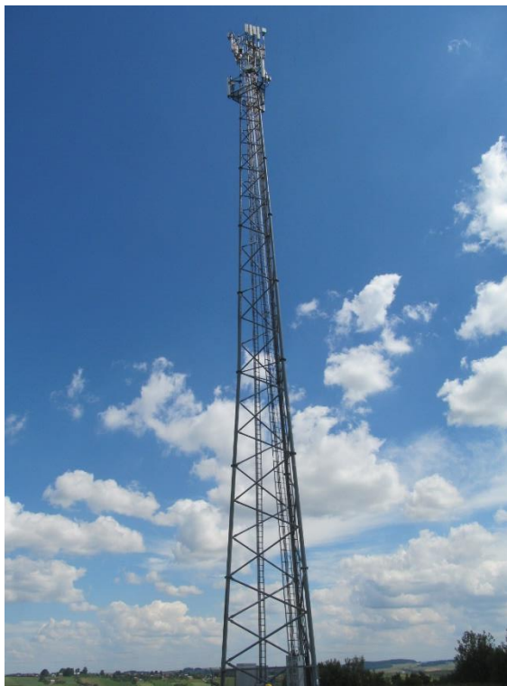
Zał. nr 1: Widok ogólny instalacji radiokomunikacyjnej.
