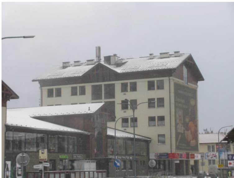
Zał. nr 1: Widok ogólny instalacji radiokomunikacyjnej.
