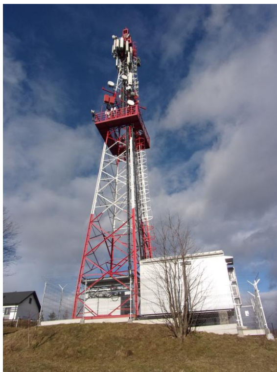
Zał. nr 1: Widok ogólny instalacji radiokomunikacyjnej.
