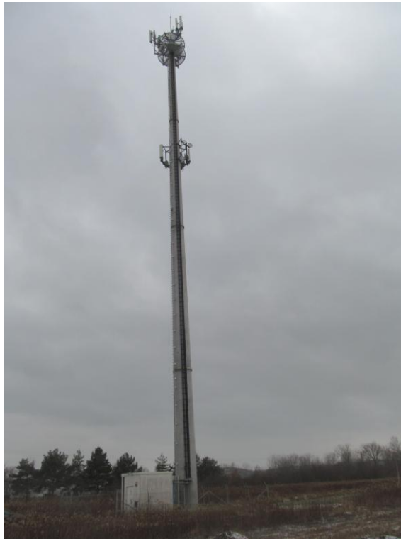
Zat. nr 1: Widok ogólny instalacji radiokomunikacyjnej.
