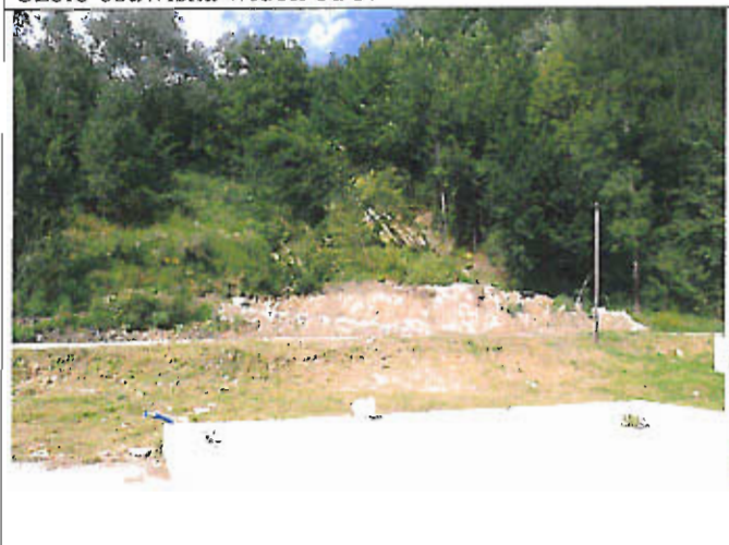
Widok na dolną część osuwiska od strony Popradu
