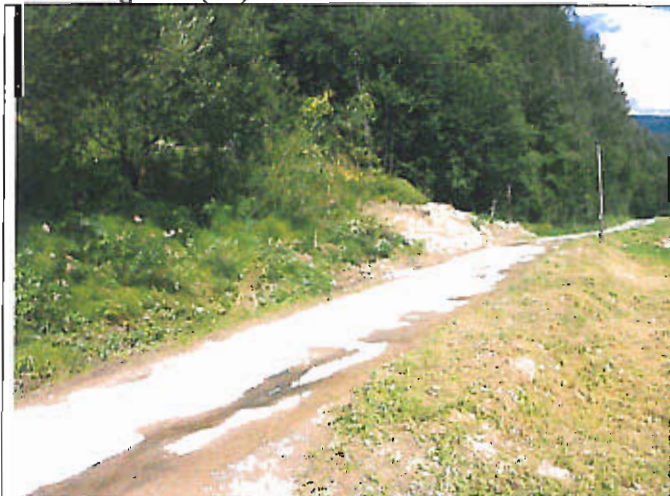
Widok na czoło osuwiska
