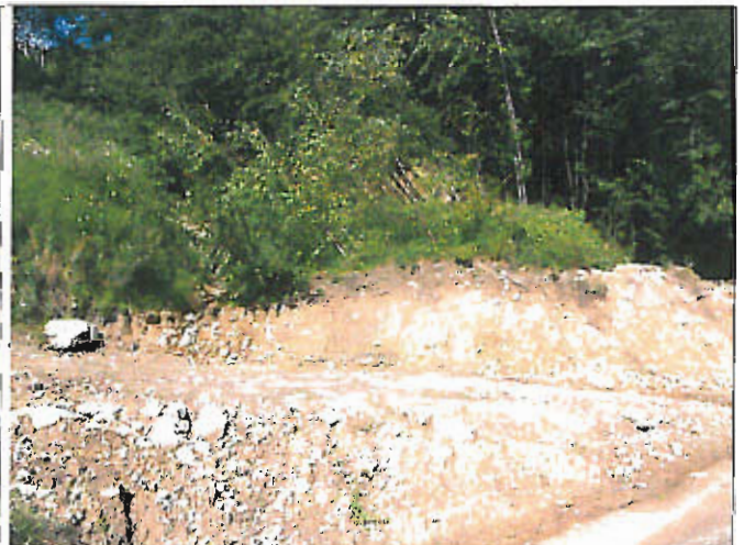
Widok na czoło osuwiska
