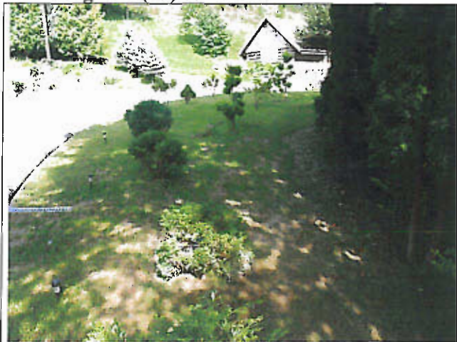
Widok górnej skarpy gdzie wystąpiły szczeliny z rozciągania
