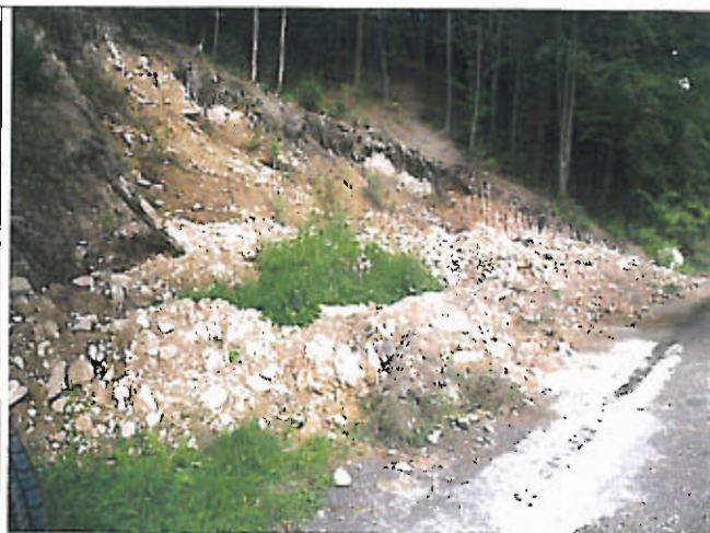
Widok na osuwisko od dołu
