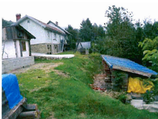
obciążenie skarpy budynkami
